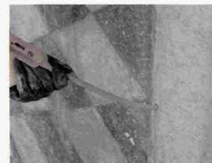
Malta di calce idraulica pozzolanica per l'iniezione consolidante e traspi-
